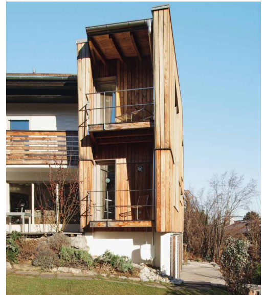
Die aus Brettsperrholz gezimmerten Tafeln wurden aus der Werkstatt angeliefert und innerhalb kürzester Zeit mit einem großen Kran über das östlich anschließende Grundstück (rechts im Bild) hinweg auf die Baustelle gehoben.
