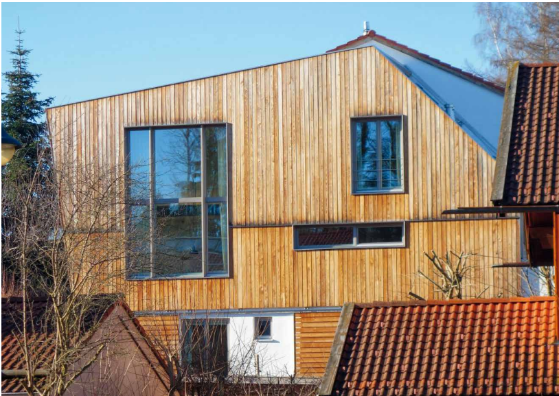
Ansicht der Ostseite, deren obere Geschosse mit Lärchenholzbrettern verschalt sind. Im Untergeschoss ermöglichen Schiebeläden, die Schlafzimmer und Bäder zu verschatten.
