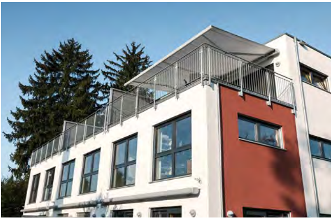
Das zurückgesetzte 2. Obergeschoss mit Dachterrasse ist den Eltern als Rückzugsort vorbehalten.
