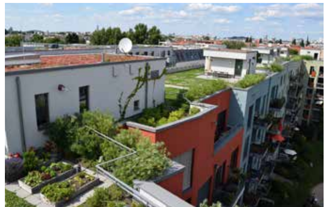
Begrünte Dächer puffern Niederschlagswasser und leiten es mit Verzögerung ab – ein Vorteil bei heftigen Regenfällen. Foto: Bundesverband GebäudeGrün
