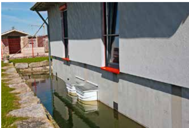
Perfekt wasserdichte Untergeschosse lassen ein Haus sogar schwimmen – wie dieses Experiment eindrucksvoll zeigt. Foto: Glatthaar
