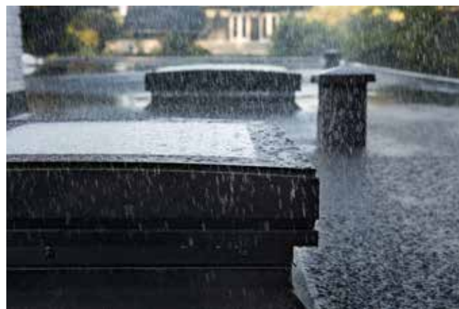
Sicherheitsglas, dichter und aus dem Flachdach auskragender Einbau: Auch Flachdächer können Tageslicht von oben bekommen und dabei gut gegen Starkregen geschützt sein. Foto: Velux
