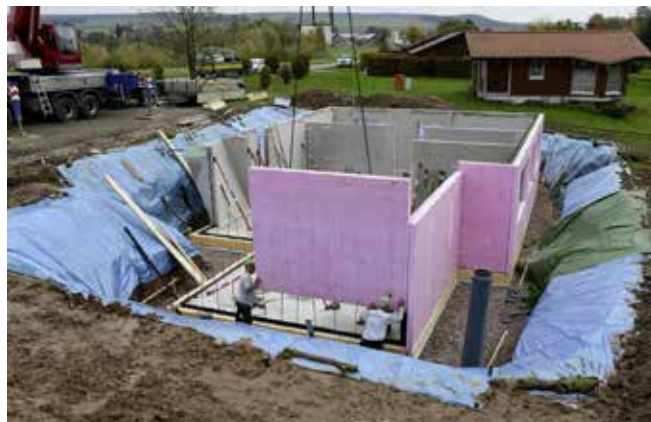
Kellerwände aus wasserdichtem Beton („weiße Wanne“) sowie eine Drainage rund ums Haus bis zur Kellersohle sind bei Neubauten die beste Vorsorge vor Wasserschäden. Foto: Knecht Kellerbau
