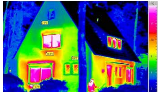
Aufnahmen mit einer Wärmebildkamera sind ein wichtiger Baustein bei der Begutachtung von Altbauten. Sie zeigen, wo die Schwachstellen des Hauses am größten sind. Foto: Verband Privater Bauherren (VPB)
