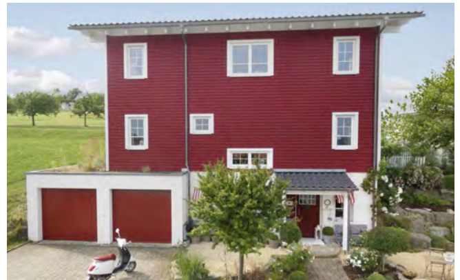
Der große Dachüberstand und die geschuppt übereinander angeordneten Bretter der Holzfassade bieten konstruktiven Holzschutz.
