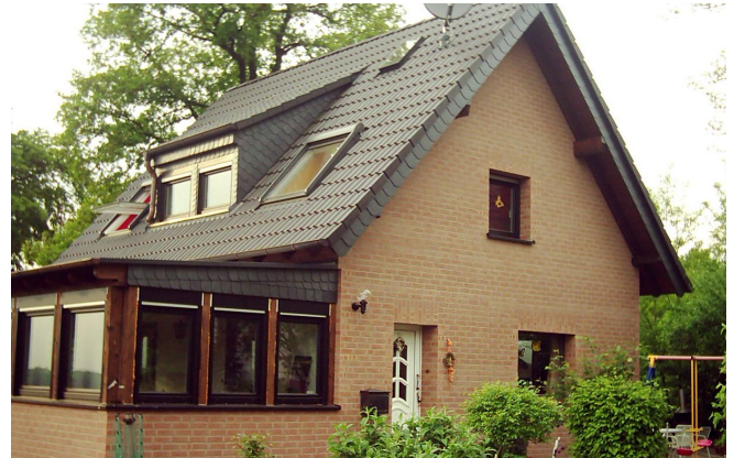
Bei der Sanierung der Außenhülle eines Hauses empfiehlt es sich, mehrere Maßnahmen im Paket zusammenzufassen. Hier wurde ein neuer Anbau dazu genutzt, auch gleich die Fassade mit Dämmklinkern zu erneuern.
