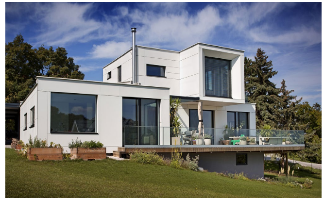
Das Haus von Lizz Görgl und ihrem Lebenspartner besteht aus sieben Modulen und kann später komplett zurückgebaut werden.
