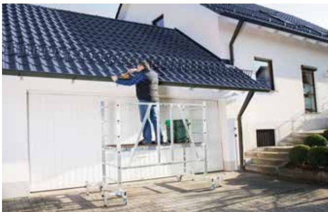
Für Arbeiten an der Regenrinne ist ein Fahrgerüst ideal.
