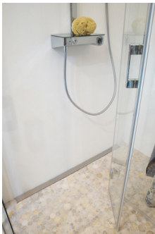
Dieser Duschbereich ist mit versiegeltem Kalk-Marmor-Putz fugenlos gestaltet. Weiterer optischer Trick: Durch den gefliesten Duschboden hat das ganze Bad einen durchgehenden Bodenbelag.
