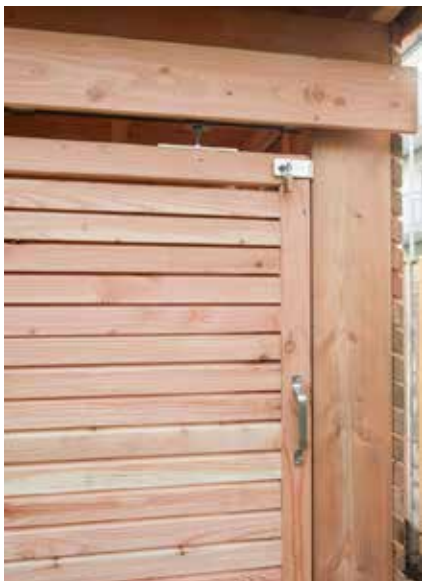
29. Die Griffe und die Sicherheits-uberfallen mit der osenplatte montieren. Jetzt ist der Bikeport abschliebar.
