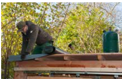
28. Die Dachabdichtung wird durch Erhitzen fest verschweit.
