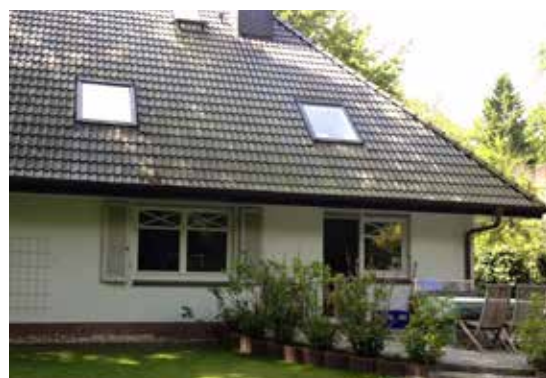
Das Haus vor dem Umbau.
