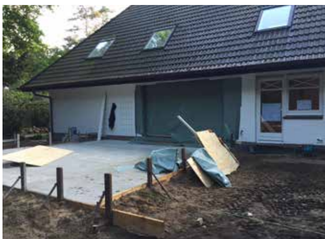
Umbau: Die Außenmauer des Hauses aus den 1970er-Jahren wurde zum Garten hin geöffnet.
