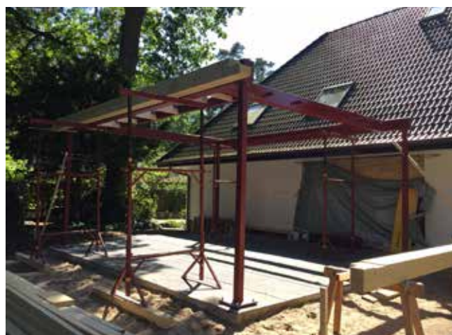
Rohbau: Eine Stahlkonstruktion wird später die Glaselemente tragen.
