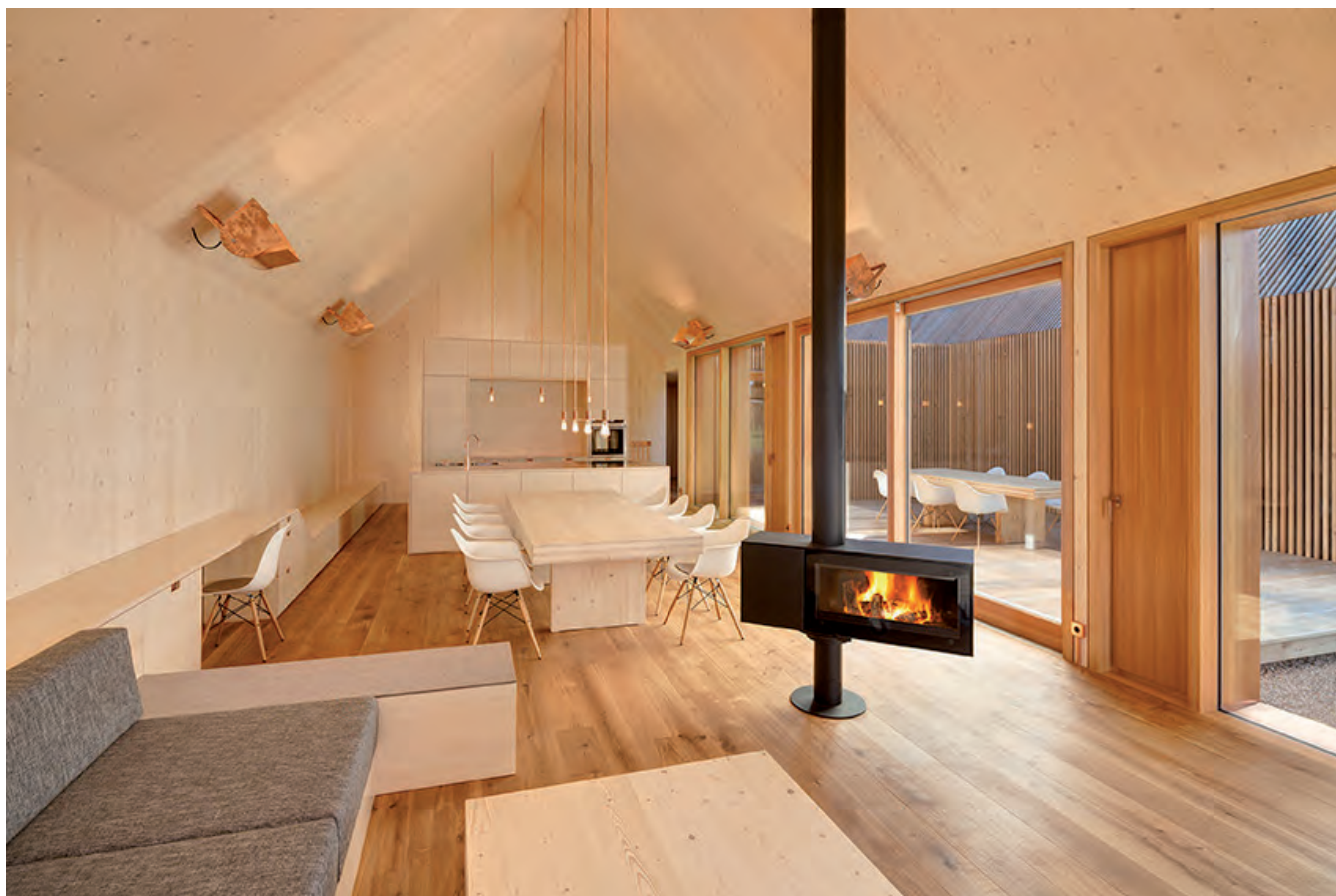
Der Wohnbereich ist bis in den First offen. Brettsper Holzplatten und Leuchten aus Kupfer tauchen ihn in eine warme Farbstimmung.
