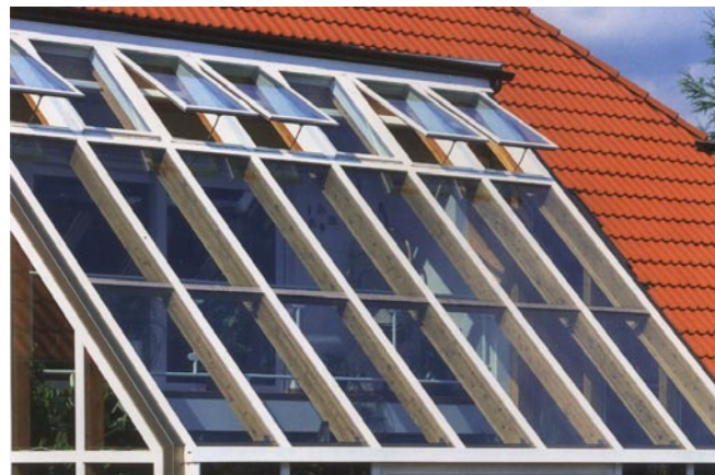
Über Schiebe- oder Kippfenster – ob manuell oder automatisch bedient – entweicht die warme, verbrauchte Luft.
