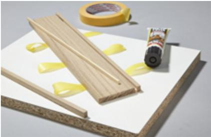
**1.** Zunächst die Seitenteile und den Deckel fertigen. Die Nuten entstehen durch eingeleimte 3x5 mm starke Mini-Leisten. Sparsam Leim angeben und mit Klebeband stramm „verspannen“.
