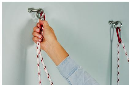
5. Nun können Sie die Metallbeschläge an der Wand anbringen. Davor den Metallring einfädeln, in ihn werden die Karabinerhaken mit Seil eingehängt.
