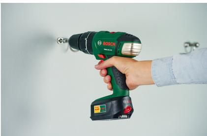
4. Mit dem Schlagbohrschrauber Löcher für die Metallbeschläge in die Wand bohren und die Dübel darin versenken. Die Abstände zwischen den Beschlägen sollten identisch zu dem Abstand der Löcher auf dem Board sein.
