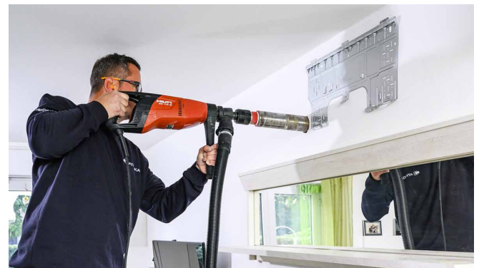
Installation einer Split-Klimaanlage: Die Bohrung für die Leitungen sitzt hinter dem Innengerät. In der Außeneinheit befindet sich die Kältemaschine, die in der Heizperiode zum Wärmeerzeuger werden kann.
