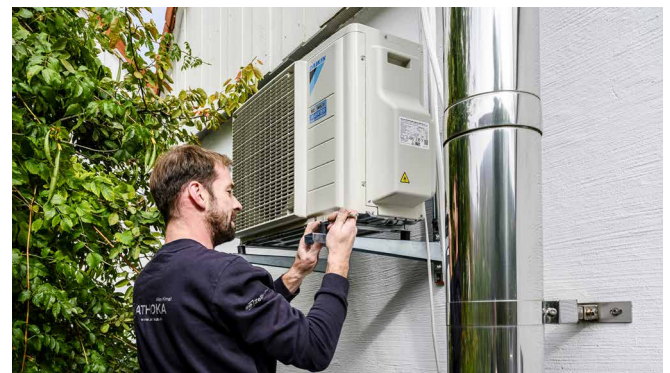
Installation einer Split-Klimaanlage: Die Bohrung für die Leitungen sitzt hinter dem Innengerät. In der Außeneinheit befindet sich die Kältemaschine, die in der Heizperiode zum Wärmeerzeuger werden kann.
